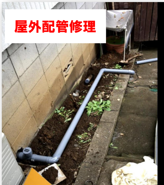
屋外配管修理
